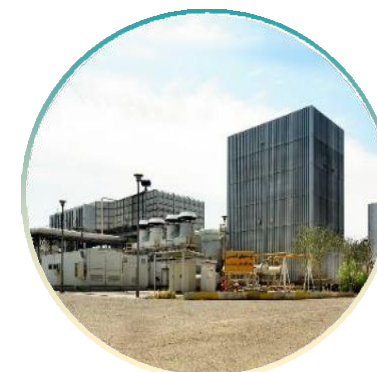
نیروگاه گازی ری
